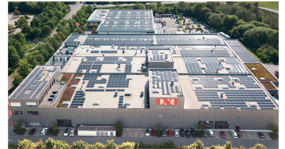
Auf dem Dach des Druckzentrums in Regensburg ist eine Photovoltaik-Anlage aus 5.000 Modulen in Betrieb, die 1.800.000 kWh Strom pro Jahr regenerativ für den Eigenverbrauch erzeugen kann.
